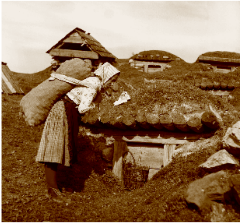
Pivnice na skladovanie zemiakov. Liptovská Teplička. J. Boďa, 1962.
